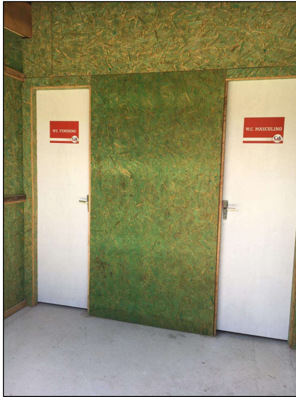
Figura 10: Banheiros do canteiro de obras Fonte: Arquivo do projeto (2019)
