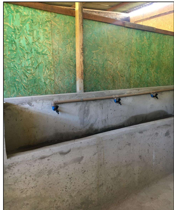
Figura 9: Área de vivência do canteiro de obras Fonte: Arquivo do projeto (2019)
