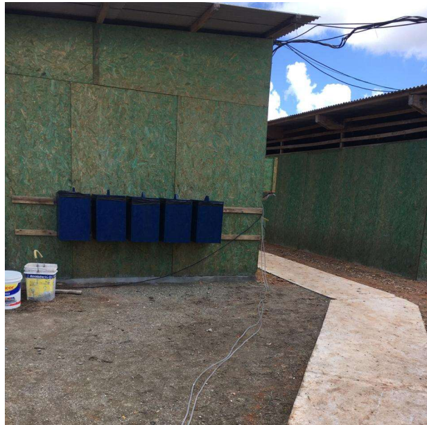
Figura 5: Recipiente para acondicionamento de resíduos do canteiro de obras Fonte: Arquivo do projeto (2019)
